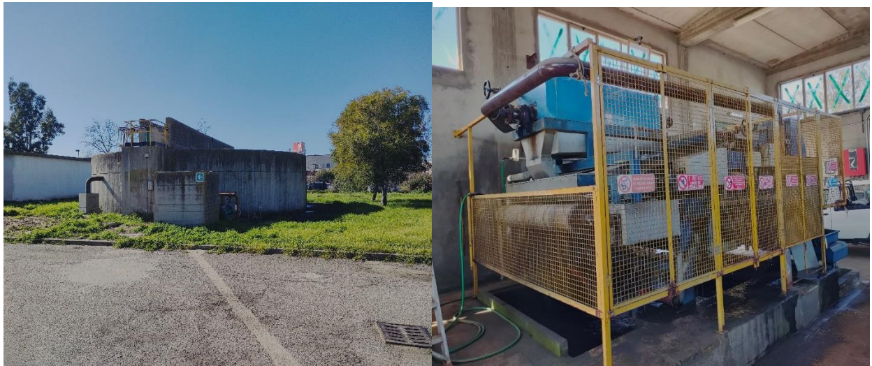
Vasca di ispessimento fanghi e nastropressa
