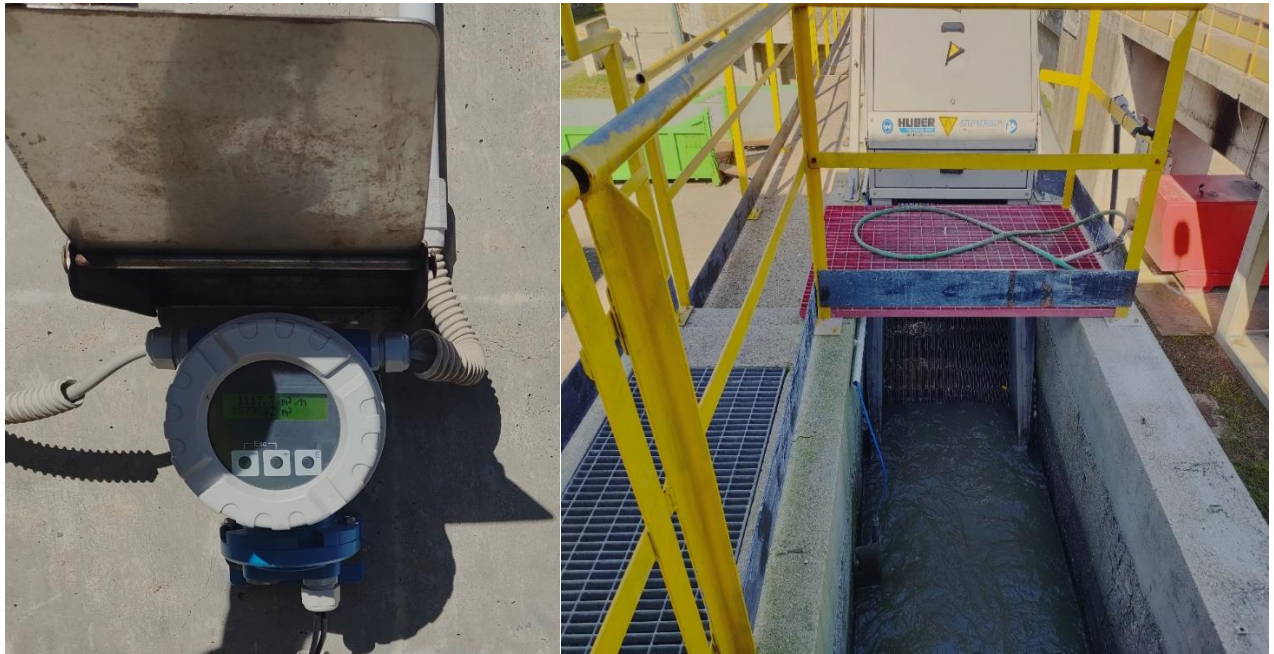
Misuratore di portata in ingresso e canale di ingresso con grigliatura
