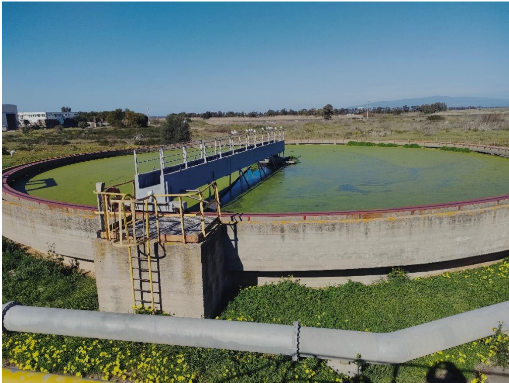
Sedimentatore secondario B
